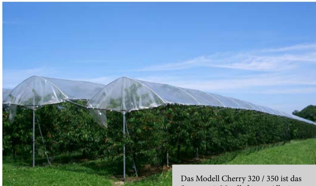
Das Modell Cherry 320 / 350 ist das System mit Metallpfosten. Alle 4m wird ein Metallpfosten mit Magerbeton gesetzt. Die Pfosten haben alle 30cm Löcher für Spanndrähte. Diese dienen als Traggerüst für die Bäume. Der Dachaufbau kann später bei Ertrag der Bäume montiert werden.
